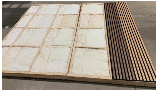
Figure 4 – Installation de panneaux sur laine minérale
