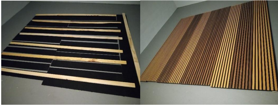
Figure 3 – Feutre et latte de bois (gauche) et montage complet avec panneaux (droite)
