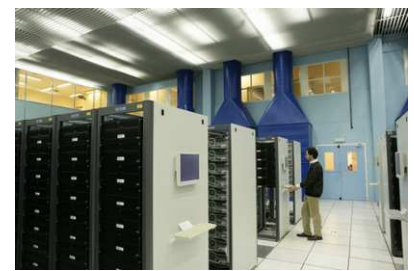
Salles des machines, menuiseries, bureaux
